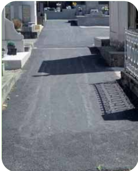
Allée en stabilisé sensible à l'enherbement
