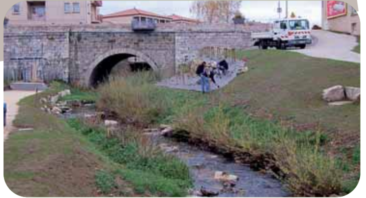
Le pont Martouret avant et après les travaux
