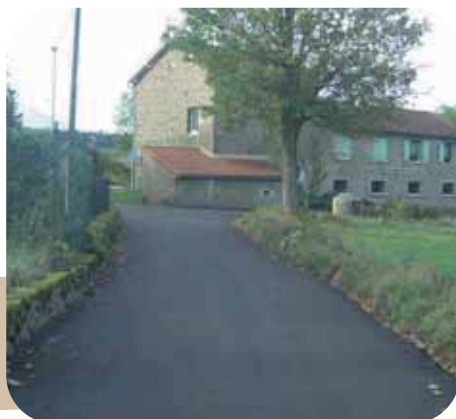
Travaux de voiries : élargissement à la Souchonne et enrobé à Praisles.
