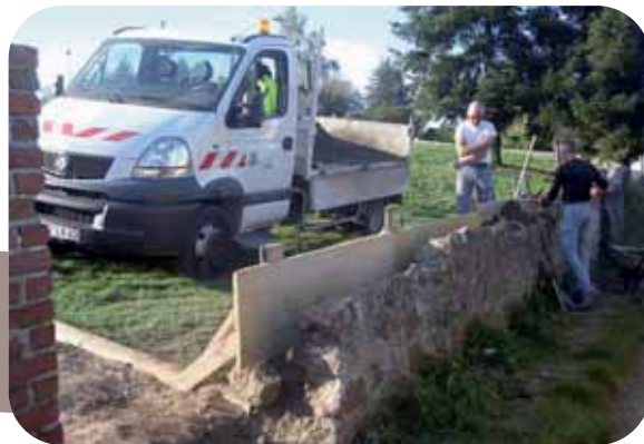
Réhabilitation du mur du Monteil
