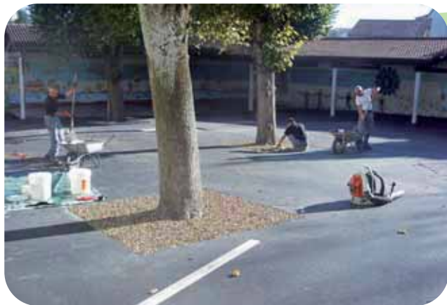
Réfection de la cour de l'école Lucie Aubrac
